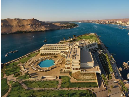
Luftaufnahme Steigenberger Hotel Elephantine Island Aswan ©Legacy Hospitality Company S.A.E
